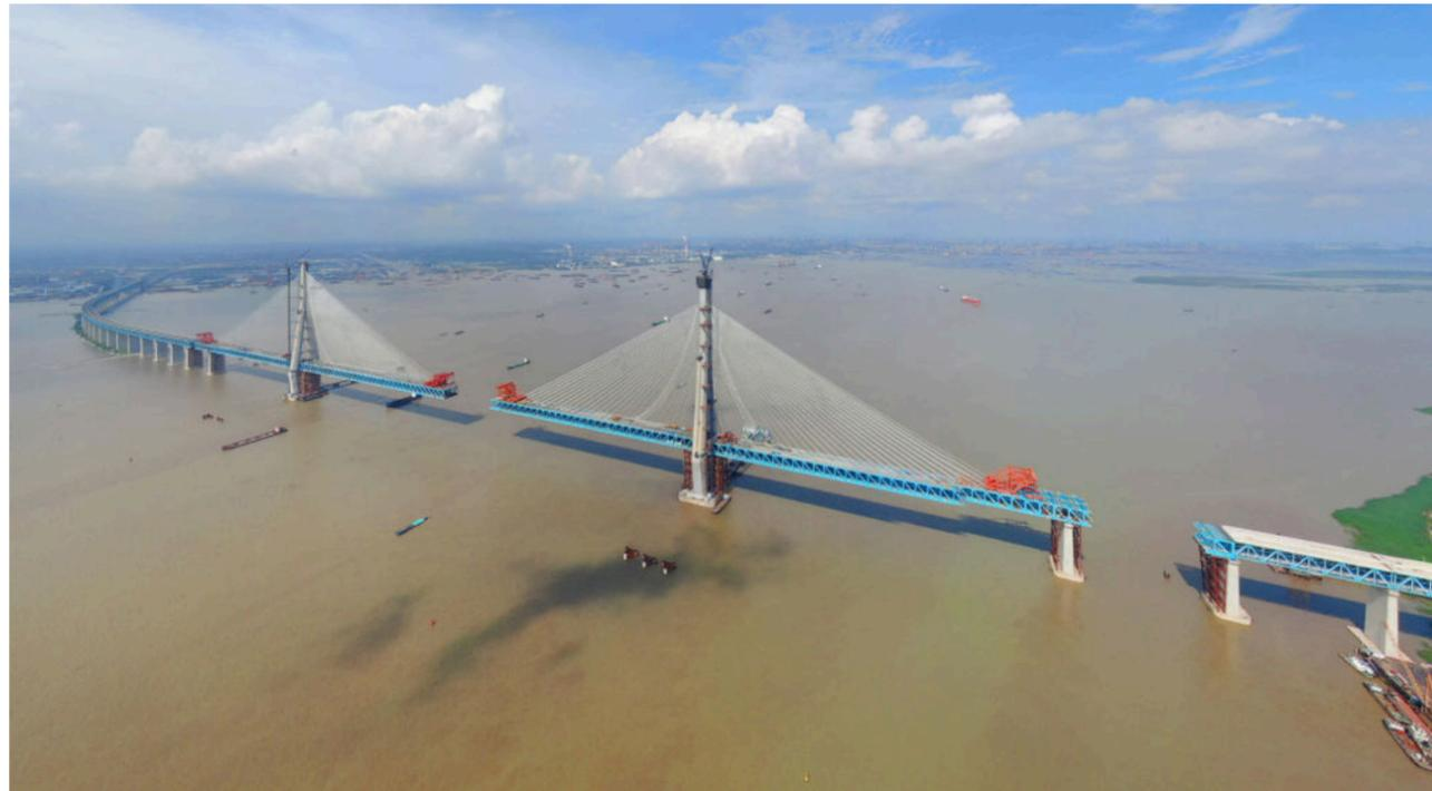
Le pont Hutong, qui relie Shanghai à Nantong, a été construit entre 2014 et 2020. Il s'agit actuellement du plus grand pont à haubans du monde ; il est à la fois routier et ferroviaire (2 x 3 routes, et 2 x 2 voies ferrées).
